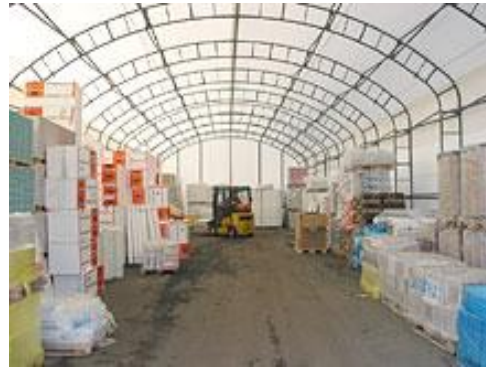
Lagerhallen und Garagen
